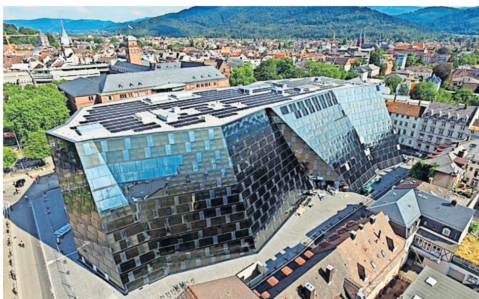
Die neue Universitätsbibliothek ist ein Thema in Freiburg – auch die Tatsache, dass an heißen Sommertagen die Südseite wegen der Blendung verhüllt werden muss. Foto: dpa
